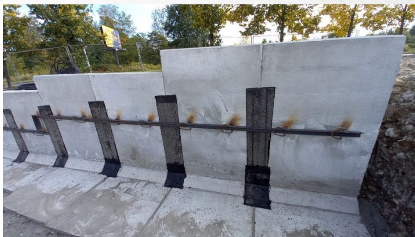
Obr. 4. Pás izolačního materiálu na spojích opěrných stěn na vnitřní straně.
