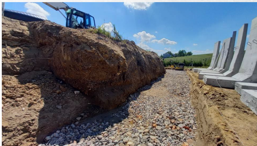
Obr. 3a. Základní vrstva z kameniva
