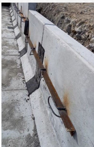
Obr. 6a; 6b. Ochrana proti "zaklínování" spojením opěrných zdí výztužnými tyčemi o průměru Ø 16 mm nebo úhelníkem 50x50x5 – před aplikací antikoročního prostředku.
