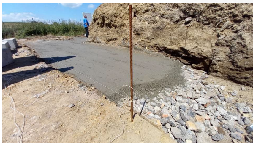
Obr. 3b. Vyrovnávací vrstva
