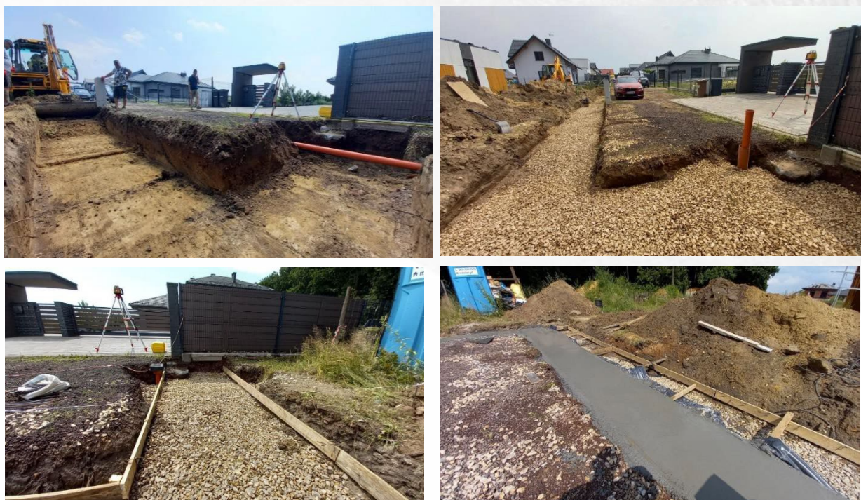
Obr. 2. Jednotlivé fáze zhotovení základu plotové zdi (výkop, plnění kamenivem, příprava bednění, zalití betonem).
