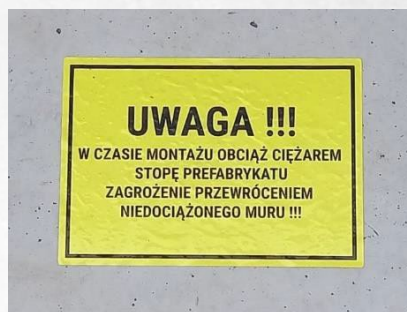
Obr. 4. Samolepka na patce stěny informující o nutnosti zatížení.
