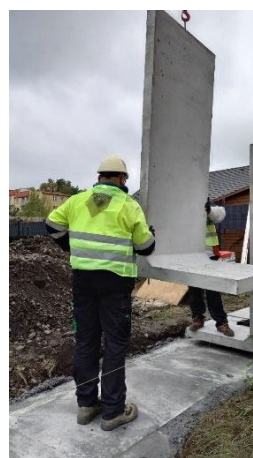
Obr. 1. Začátek pokládky plotových zdí na připravený podklad.
