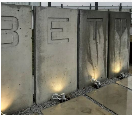
Obr. 6. Vlevo stěny napuštěné impregnátem LOVBET, vpravo bez impregnace
