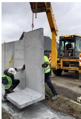
Obr. 1. Začátek pokládky plotových zdí na připravený podklad.
